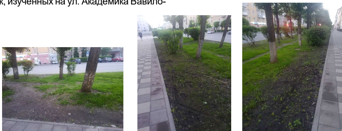
Рисунок 6. Повреждения газона в месте примыкания к тротуарам
