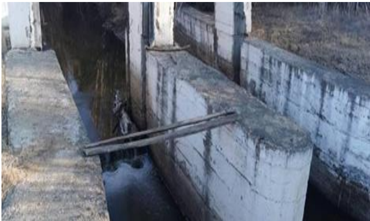
Рисунок 3 - Головное водозаборное сооружение Халютинской оросительной системы
