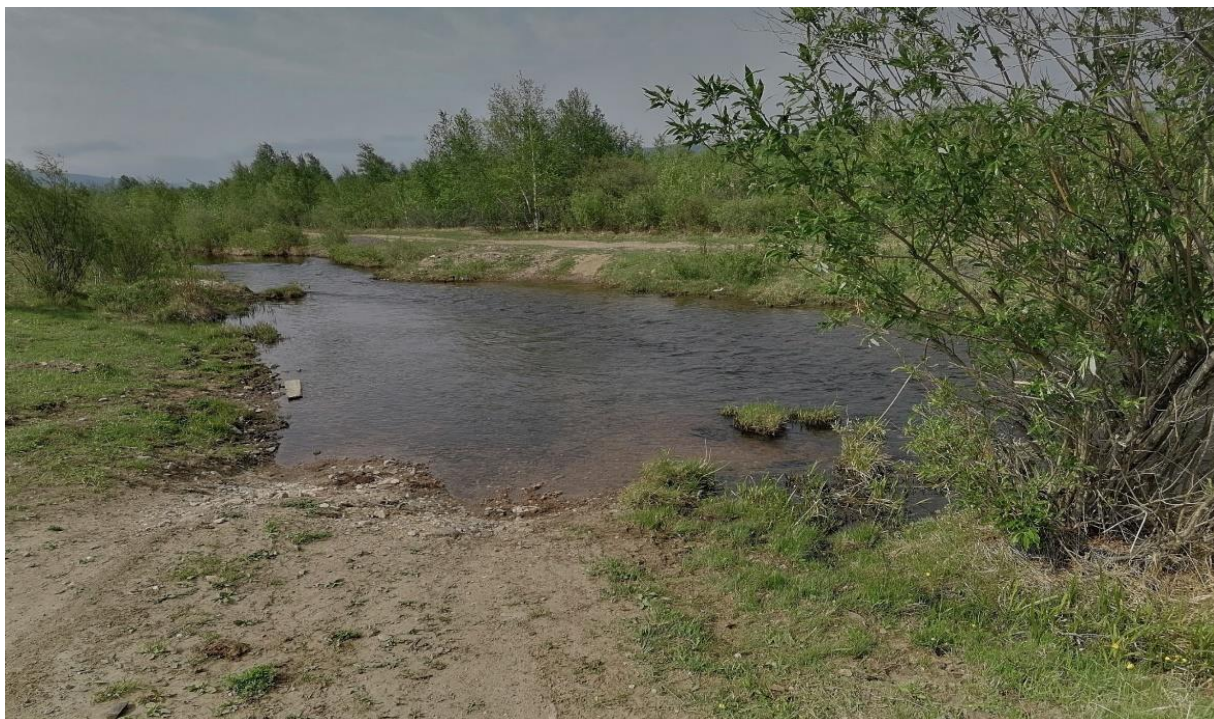
Рисунок 2 – Магистральный канал Халютинской оросительной системы
