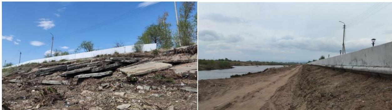
Рисунок 1 – Состояние защитной дамбы рек Селенга и Уда
